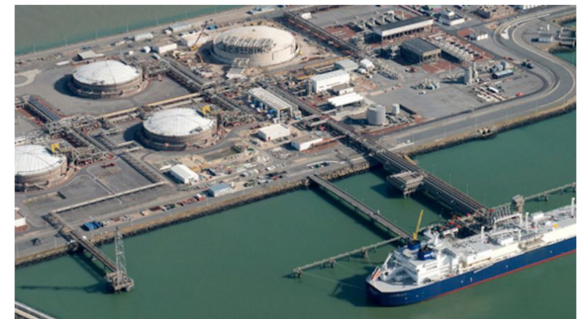
LNG terminal Zeebrugge
